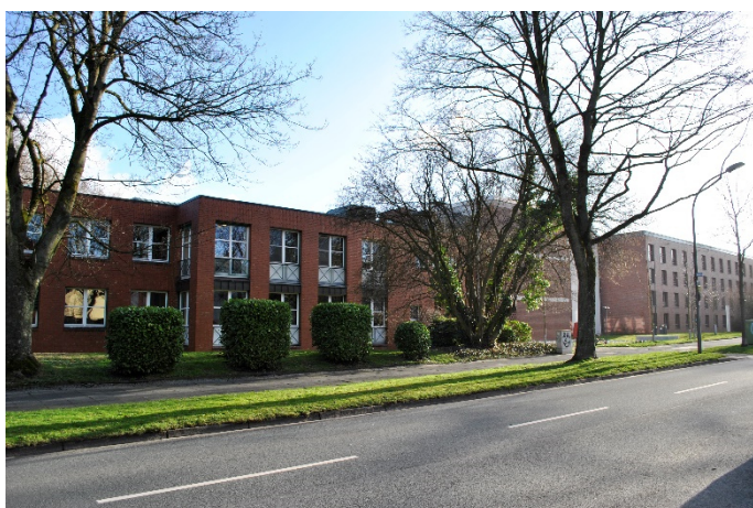
Abbildung 2: Gebäude der Evangelischen Hochschule (Abbildung NRW.URBAN)
